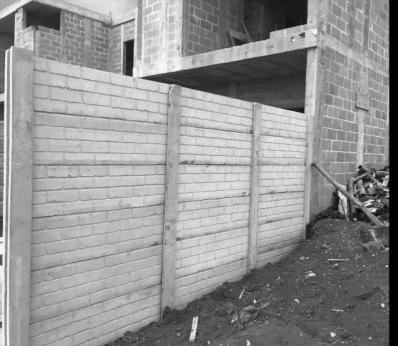
No se recomienda apoyar sobre el muro objetos o elementos que superen la capacidad de carga del muro. No es un muro de contención.
