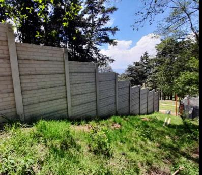
Limpieza regular de gramas o cualquier otro tipo de vegetación y raices que puedan adherirse al muro y dañar la forma del muro.
